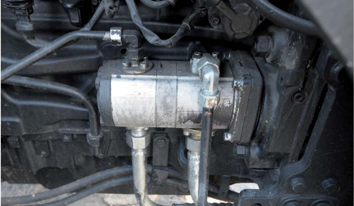
Sprawdzenia stanu technicznego wymaga pompa układu hydraulicznego i kierowniczego
